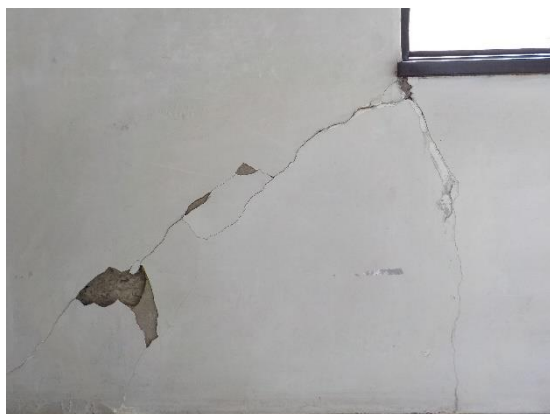
窓枠の下に生じた亀裂（第1庁舎）
