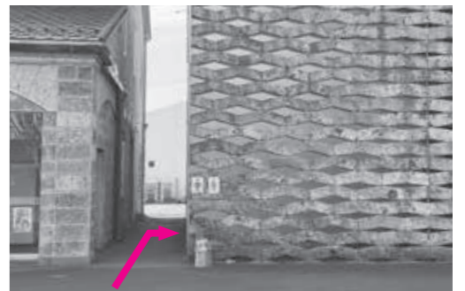
薄暗く入りにくいトイレ
