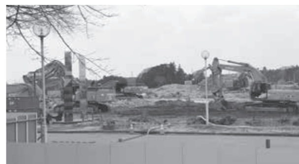
解体された町民ホール 令和8年3月
