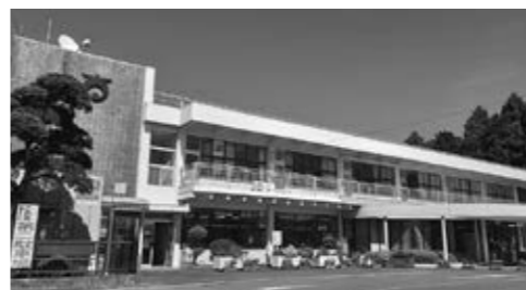
築59年を経過した役場庁舎
