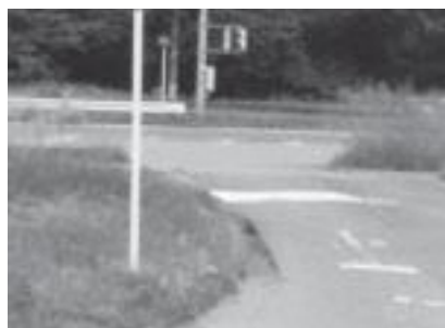
改良が望まれる原地区内の町道
