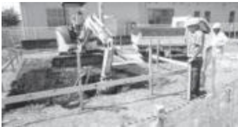
整備中の移住・定住・創業支援施設建設 今後の取り組みに期待
