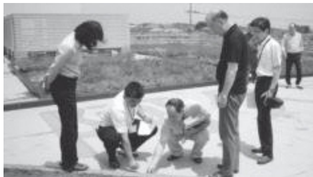
2年点検後の対応を確認 屋上部の保護モルタルのひびと欠損を指摘!!
