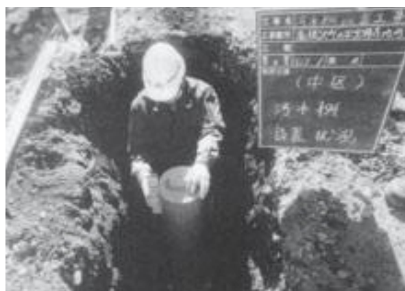
汚水樹設置工事
