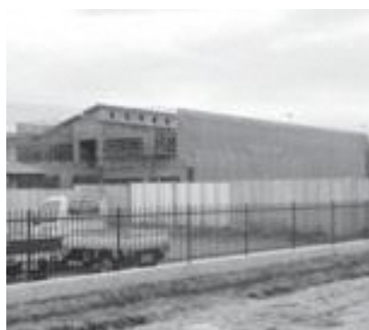
建設の槌音が高い。東小学校
