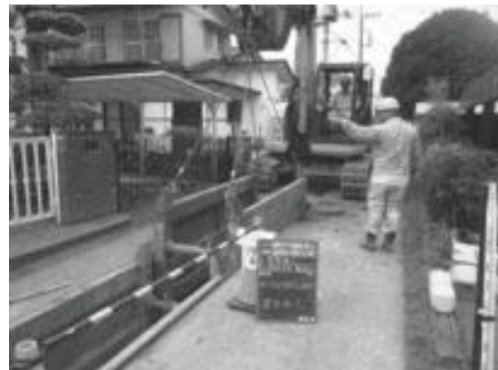
管渠建設工事
