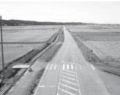
道路の改修で安全で快適な運転を
