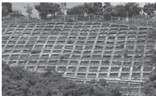
平和台地区で行われた対策（法面工事）
