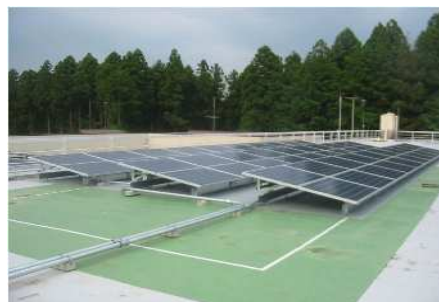
太陽光発電パネル（役場本庁舎）
