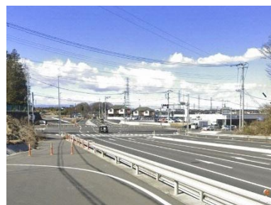
国道408号宇都宮高根沢バイパス
