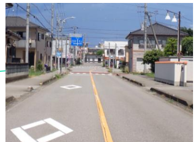
都市計画道路仁井田中央通り
