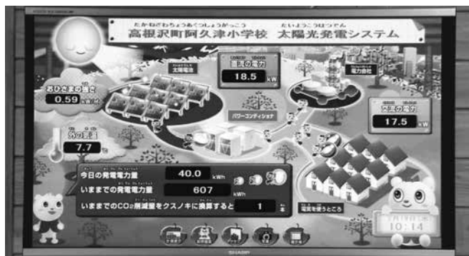
▲屋根に設置した太陽光発電装置のモニター
