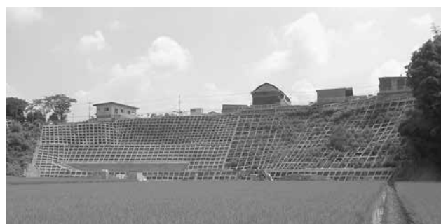
▲災害復旧工事を終えた宝積寺中坂地区
