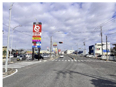
写真：主要地方道宇都宮那須烏山線沿線
