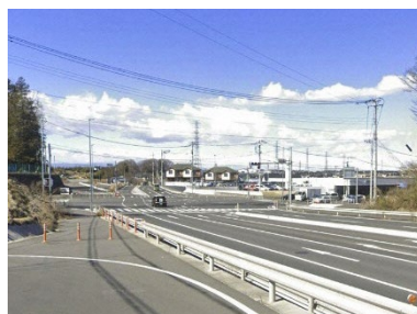
国道408号宇都宮高根沢バイパス
