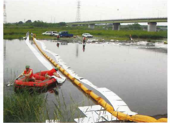
油除去作業の様子（オイルフェン設置）
