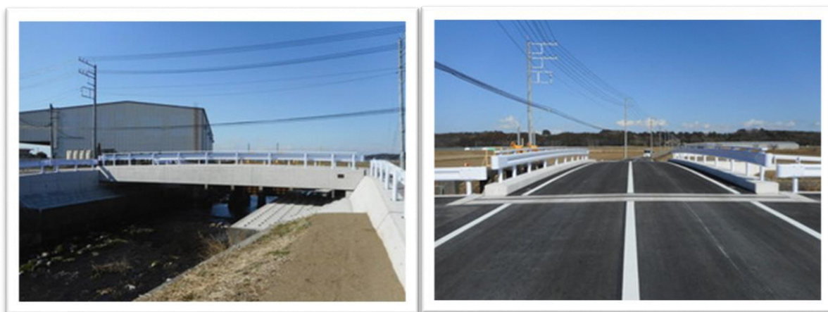
対象施設の一例（421-7 号橋）
